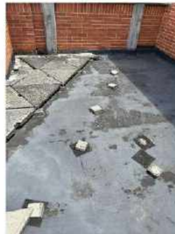
Fotografía N.2. Levantamiento del acabado
